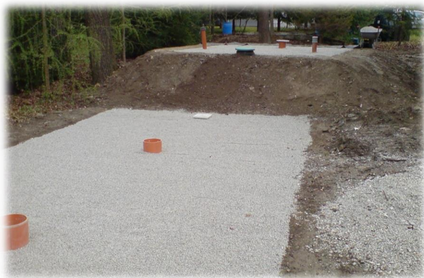
Rastlinska čistilna naprava LIMNOWET 20 PE v HE Medvode
