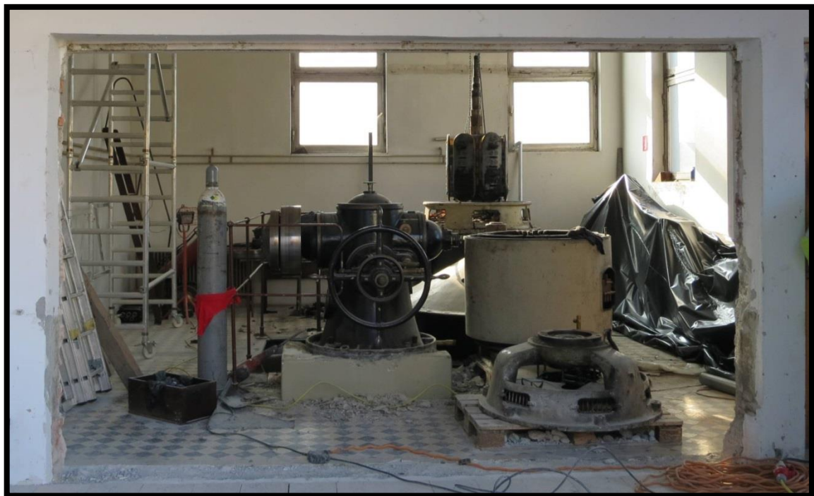
MHE Goričane – demontaža starega agregata
