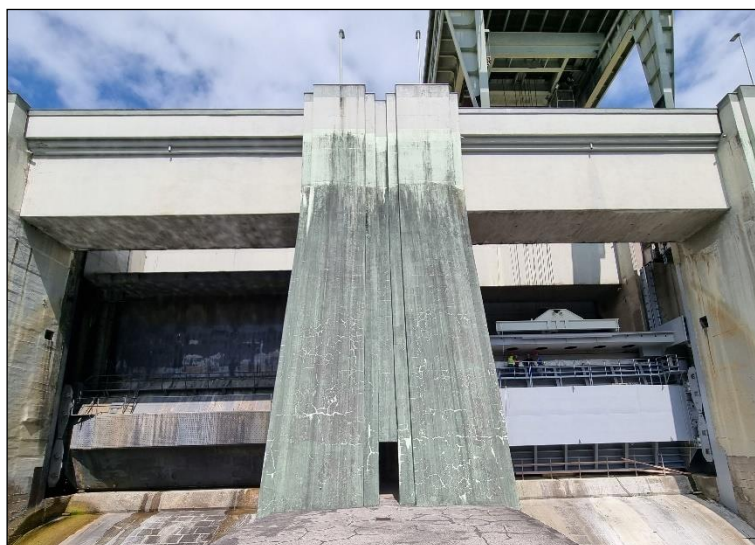
Vgrajene nove zapornice na prvem prelivnem polju
