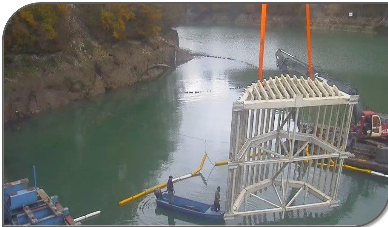
Vgradnja rešetke talnega izpusta
