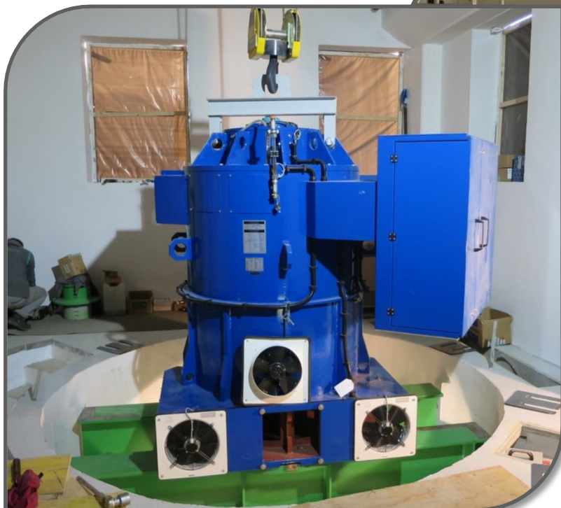
MHE Goričane – montaža novega agregata
