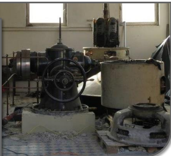
MHE Goričane - demontaža starega agregata iz leta 1931
