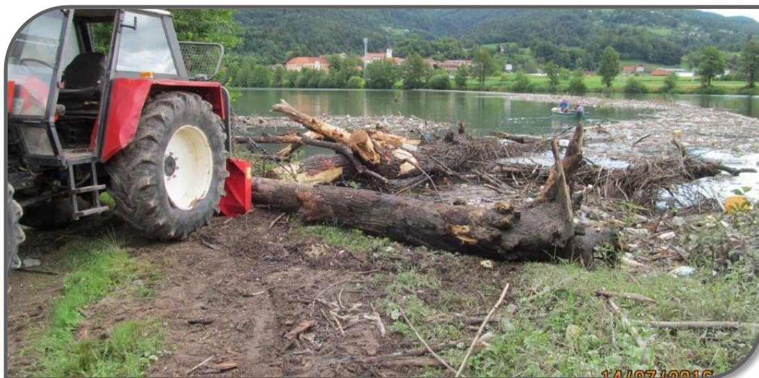
Čiščenje baraže Hotemež
