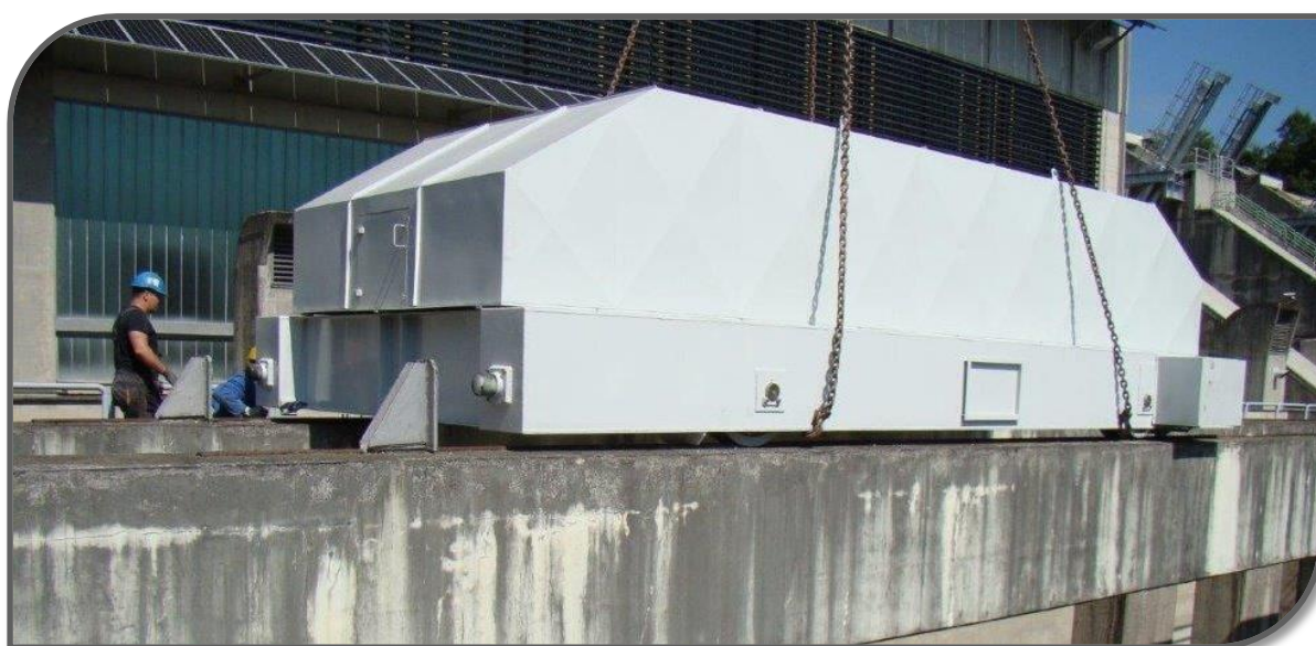
Montaža obnovljenega dvižnega mehanizma iztočnih zapornic v HE Mavčiče
