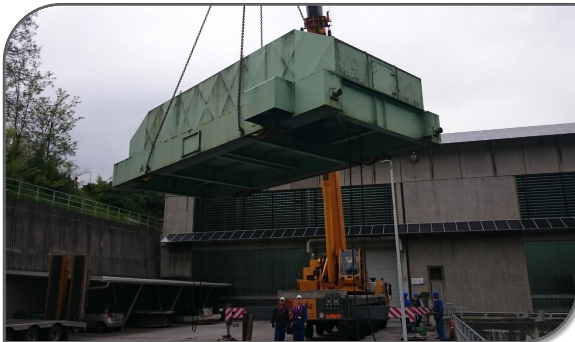
Demontaža iztočnih zapornic v HE Mavčiče
